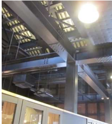
建築物の内部に鉄骨フレームが充填され内部から煉瓦造である事が分からなくなっている保存活用事例
