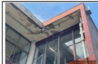
No.3 コメント 塗装剥がれ、ひび割れ
