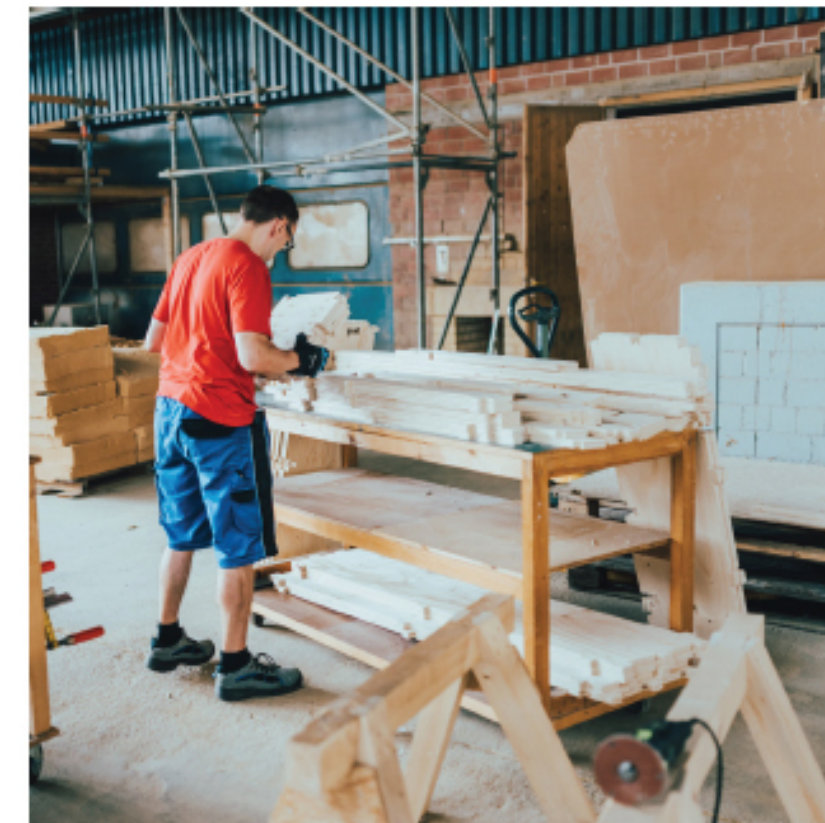
Im interdisziplinären Austausch wurde die Prozesskette für die Produktion vermittelt und optimiert sowie die Montage des Systems evaluiert.
